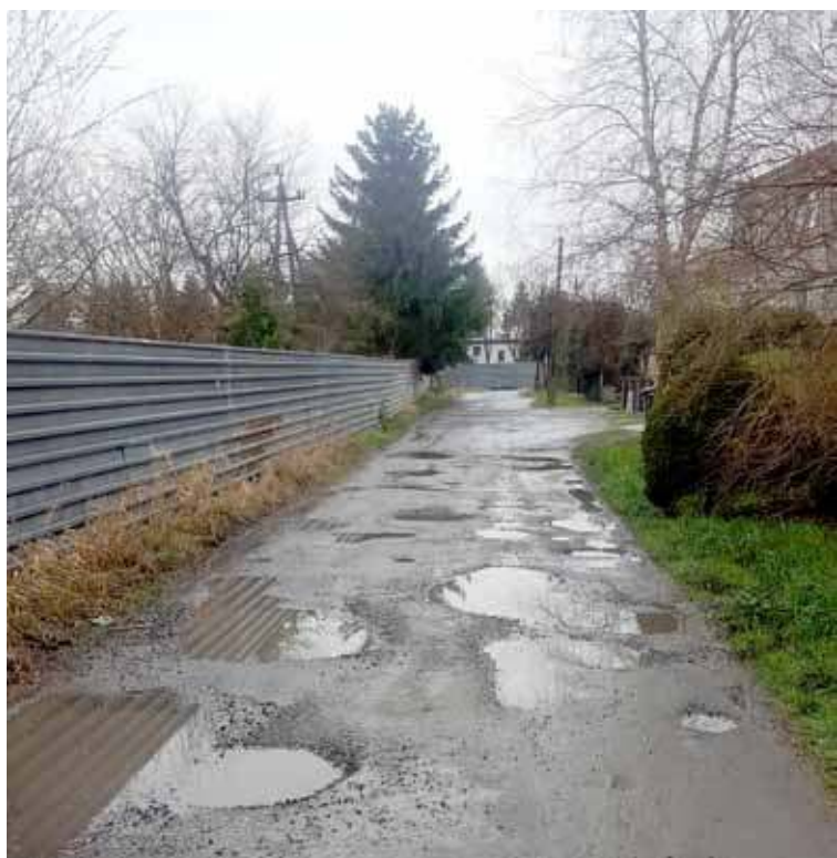
Sporej wielkości koleiny w drodze gruntowej powodują, że bardzo łatwo tworzą się tutaj kałuże
