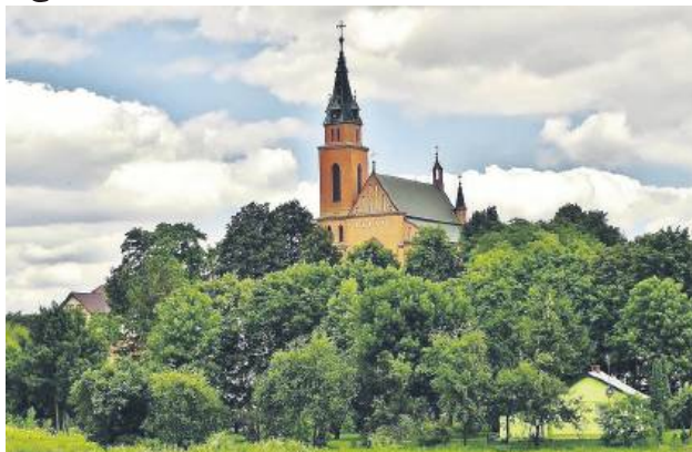
Śledczy z Hrubieszowa nie dopatryli się niczego zabronionego w remontach modernizacji neogotyckiego kościoła w Trzeszczanach ani w rozliczeniu rządowego dofinansowania na realizację tych robót.
