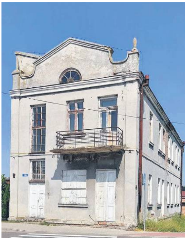
Budynek znajduje się w centrum Tyszowiec.
