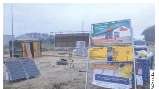
Obok drogi S17 w Żyrzynie pojawi się kolejny market. Od ponad 2 miesięcy trwa budowa sklepu „Dino”. Otwarcie przewidziano wiosną 2025 r.
