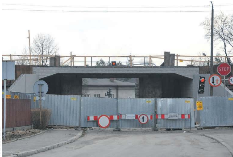
Wiadukt nad ul. Kadłubek
