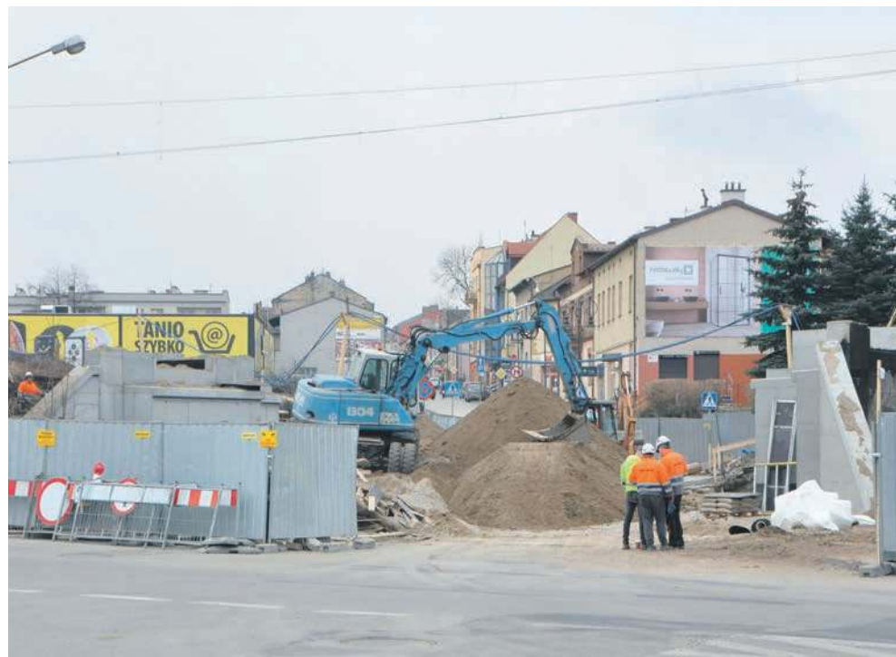
Widok na przebudowywany wiadukt nad ul. Krakowską
