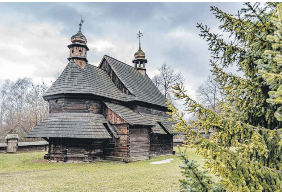
Kościół z Nieboczów z 1791 roku
