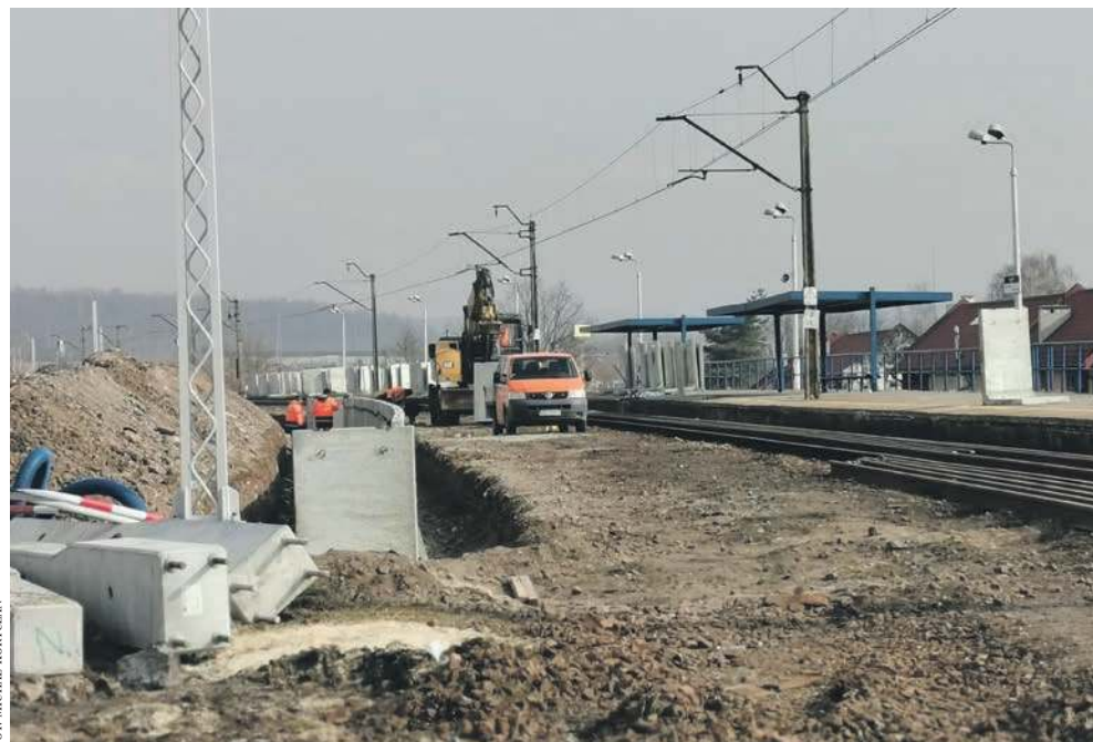
Prace w rejonie stacji kolejowej Chrzanów Śródmieście
