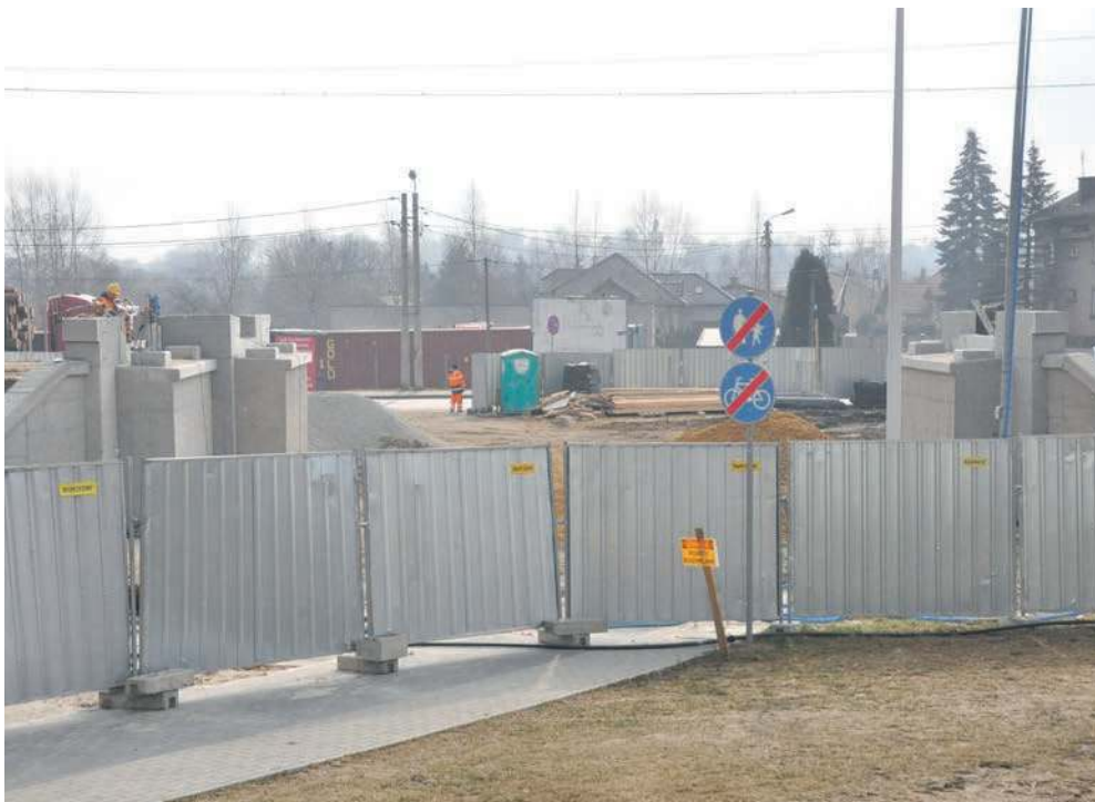
Wiadukt nad ul. 29 Listopada
