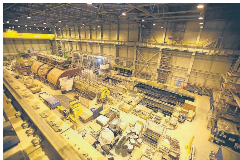
Wykorzystane technologie pozwolą zmniejszyć negatywny wpływ elektrowni na środowisko
