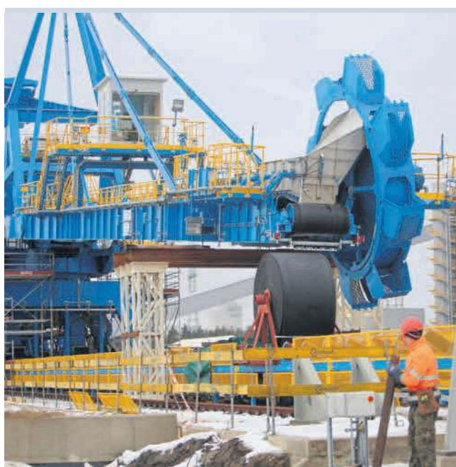
W 2018 r. średnio każdego dnia na budowie pracowało 2190 osób
