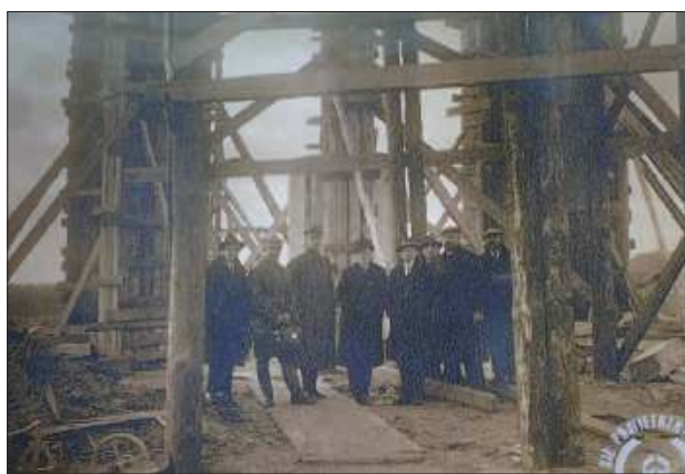
■ Budowa wieży ciśnień. Powstała w 1924 roku na rzecz dęblńskiego garnizonu i zaopatrywała w wodę cały kompleks lotniska. Budynek jest nieużytkowany, ale niebawem ma zyskać nowe życie
