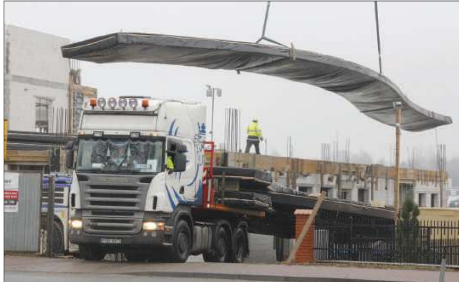
■ Do rozładunku konstrukcji trzeba było użyć specjalistycznego dźwigu
