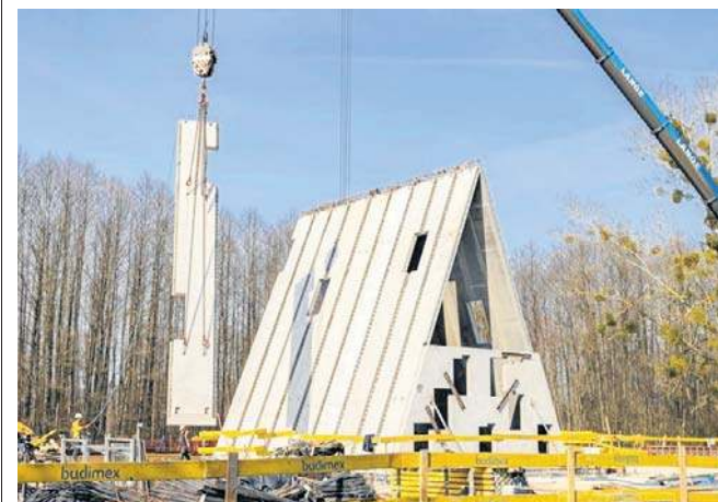
Montaż dachu to ważny moment budowy muzeum. Dzięki temu widać już ostateczny kształt budynku
