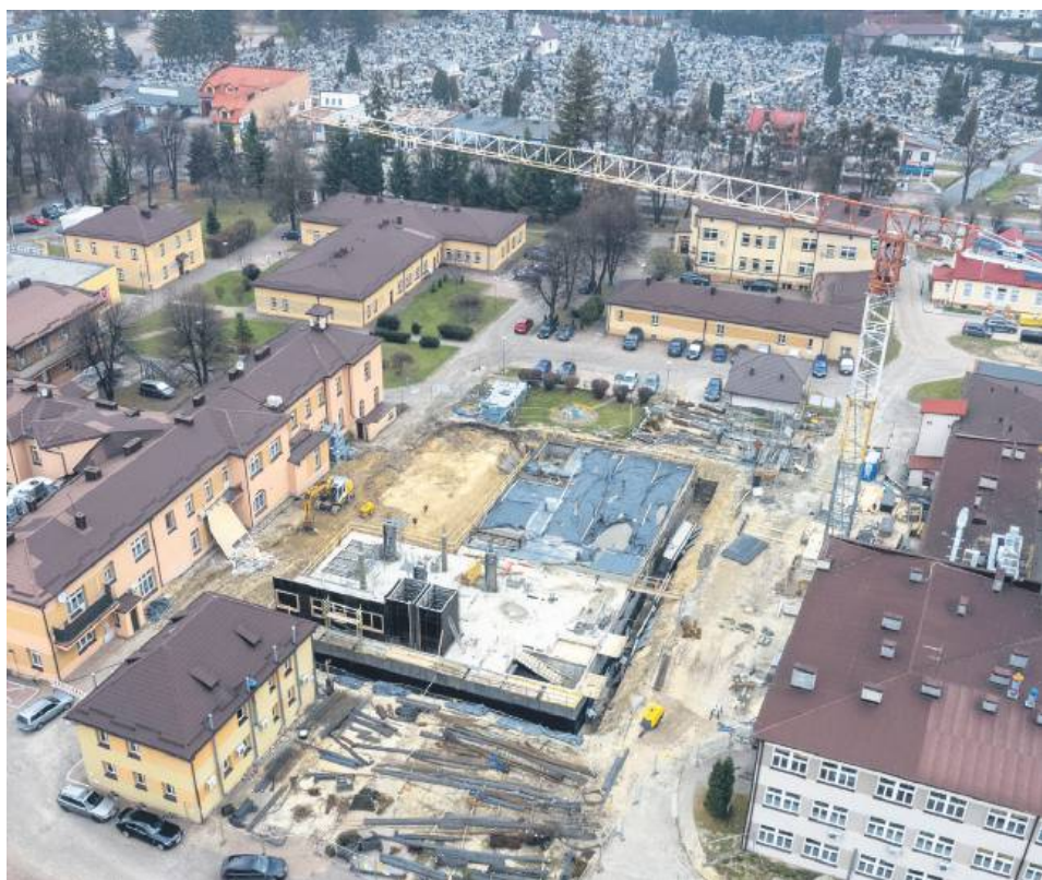
Na terenie powiatowego szpitala trwa rozbudowa.
