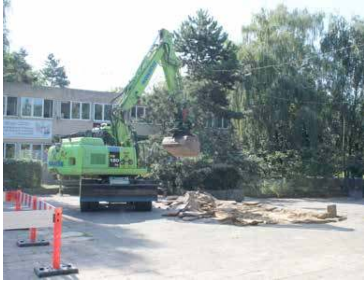
Część prac ma w ramach II etapu robót na pl. Wolności odbywać się również w bibliotece. Całościowego harmonogramu prac nie podano, ale wygrodzono cały plac, MBP i NDK
