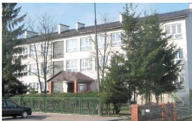
Akcja wypompowywania wody trwała blisko cztery godziny. Woda pojawiła się w piwnicy szkolnego budynku
