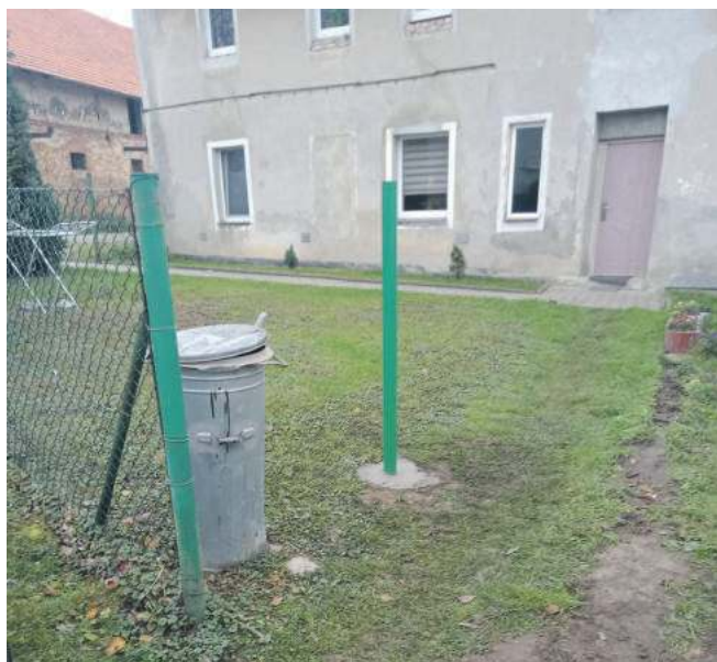
Sąsiad wyciął słupkę ogrodzeniową i zamontował go tak, aby móc zaparkować swój samochód na podwórku, na co oni nie wyrażają zgody
