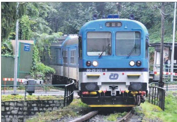
Powódź poczyniła znaczne szkody w infrastrukturze kolejowej w Czechach
