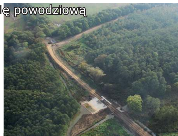
Poldery zalewowe w okolicy Żeleznika z lotu ptaka. Widoczne groble w trakcie naprawy, przelew awaryjny i tereny, na których woda może się rozlewać. Foto: Archiwum Nadleśnictwa Henryków
