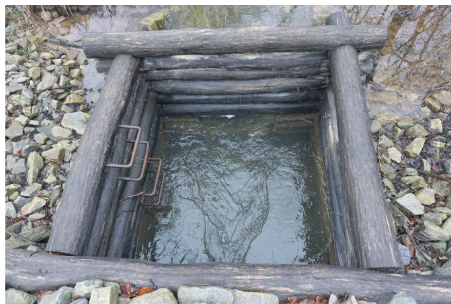
Upust denany, który został odtworzony przez henrykowskie Nadleśnictwo w ramach realizowanego projektu. Foto: Archiwum Nadleśnictwa Henryków
