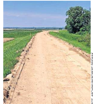
Nowy odcinek powstaje na koronie wału Dunajca
