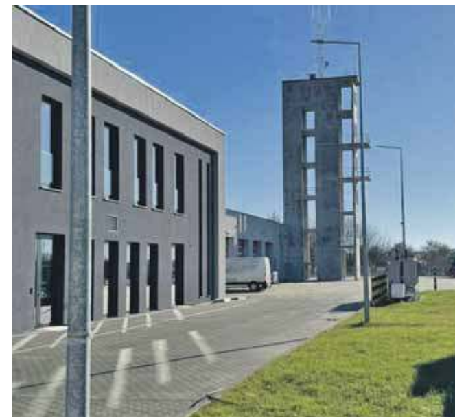
Charakterystycznym elementem nowej strażnicy jest wysoka wieża ćwiczeń
