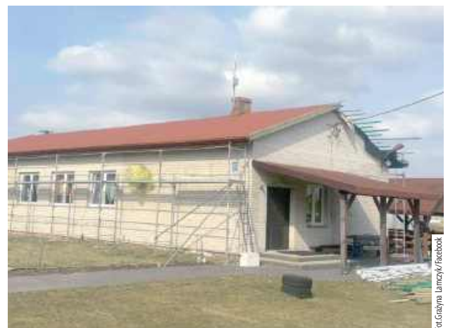
Inwestycja znacząco poprawi stan techniczny i estetykę budynku
