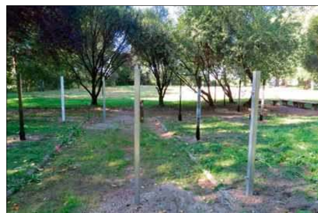
Słupki pod ogrodzenie i służę wejściową już są.
