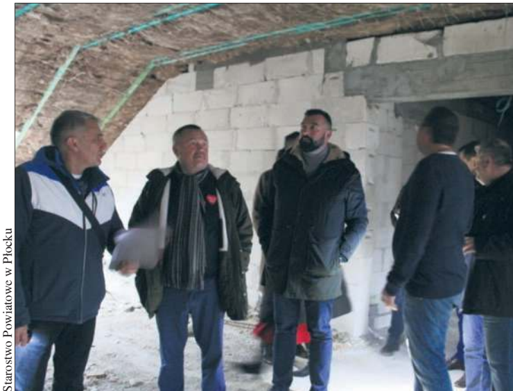
Przedstawiciele władz powiatowych obejrzały prace wykonane w ramach I etapu odbudowy miszewskiego DPS-u
