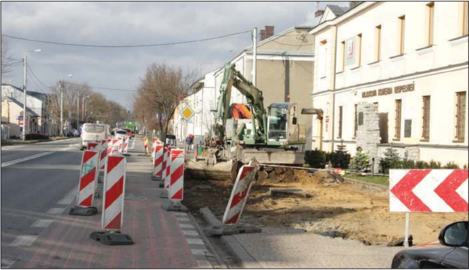
Prace mają postępować sukcesywnie -najpierw chodniki, a potem wymiana asfaltu. Na zdjęciu roboty przy WKU
