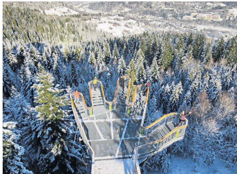
Wieża widokowa stanęła „na dachu” Wisły, czyli górnej stacji kolejki krzesełkowej Skolnity. Budowlę wyróżniają balkony widokowe w kształcie ogromnych dłoni
