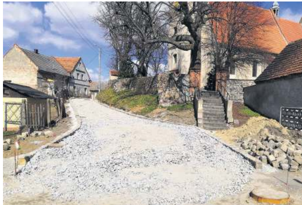
Prace na drodze w Starym Wiązowie są już mocno zaawansowane
