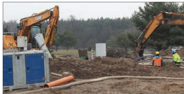
Przy ulicy Rokickiej trwają prace ziemne związane z przebudową sieci wodno-kanalizacyjnej oraz energetycznej, które kolidują z budową obwodnicy
