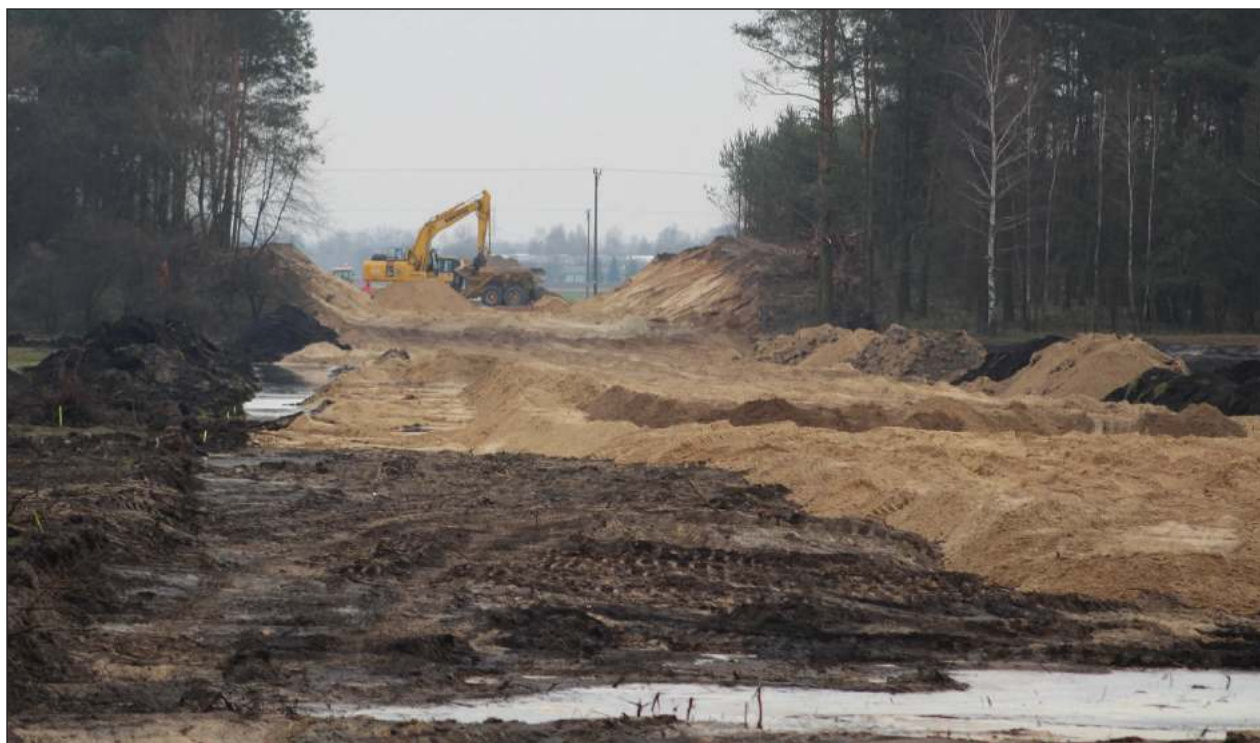
Na całym odcinku wykonawca realizuje prace przygotowawcze do wykonania podbudowy jezdni
