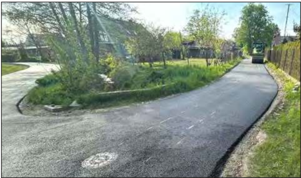
Rada Gminy Sobolew rozdysponowała ponad 3 mln zł na nowe i wcześniej uchwalone inwestycje, obejmujące m.in. kanalizację, drogi i nowy kort tenisowy
