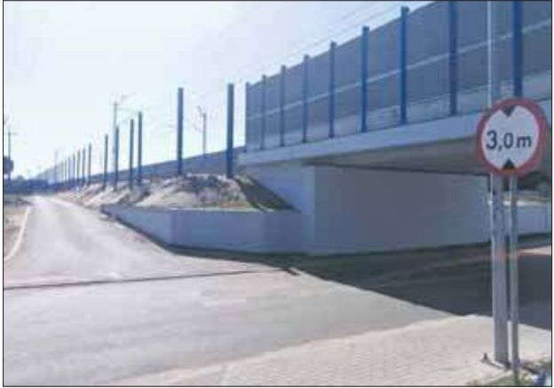
Po wielu perturbacjach, budowa wiaduktu dobiegła końca
