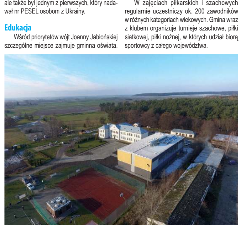
To będzie pierwsza w gminie sala sportowa z prawdziwego zdarzenia
