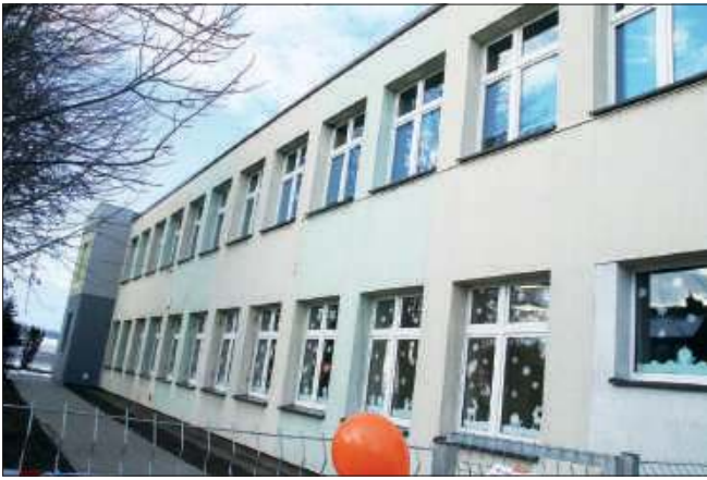
To w tym skrzydle rudnickiej placówki za funkcjonowało przedszkole. Na końcu widoczna jest część, która wyróżnia się na tle całego budynku – to dobudówka, która powstała na cele placówki.
