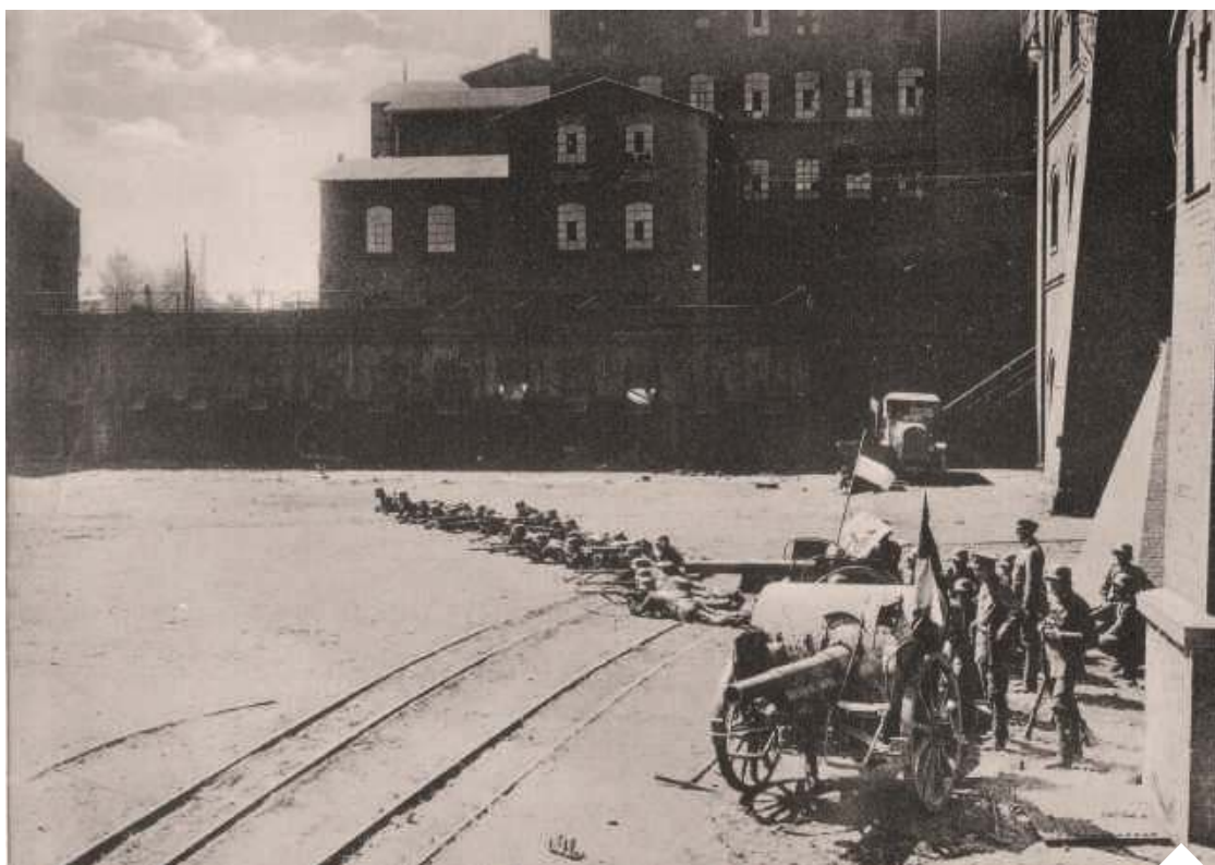
Grenzschutz w kopalni Mysłowice, 1919 r. | fot. arch.
