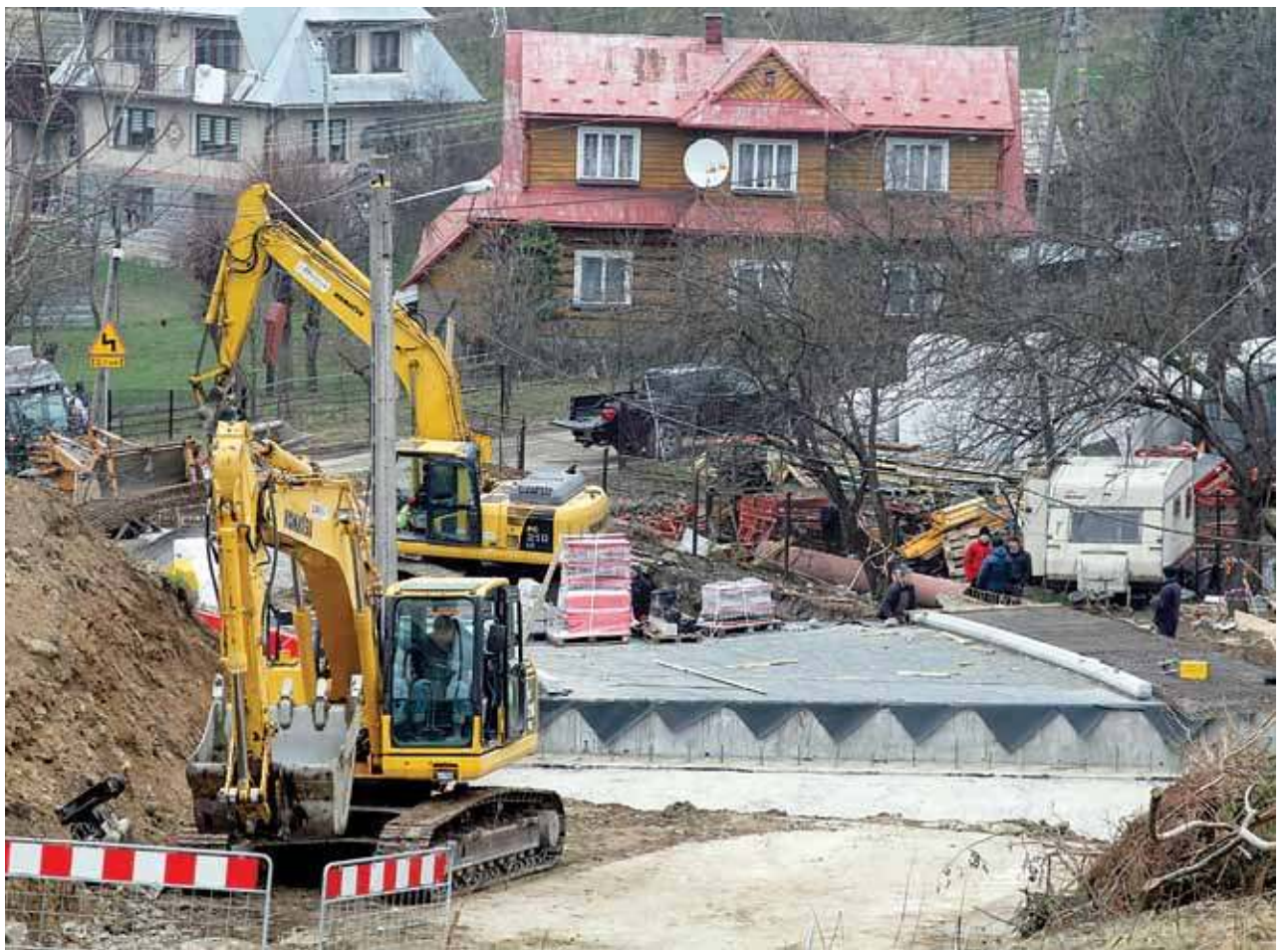
Nowy most w Rdzawce już prawie gotowy.
