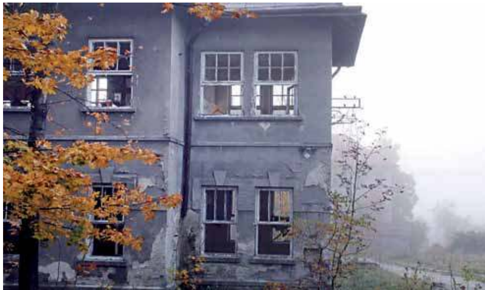
Jeden z budynków, który czeka rozbiórka.
