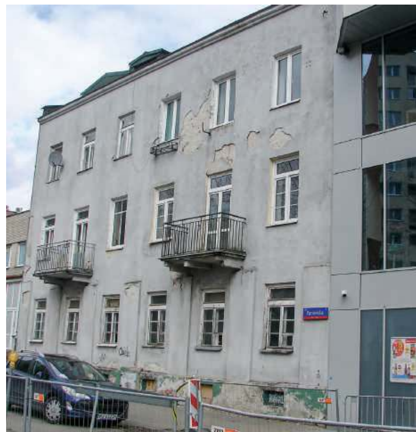
Kamienica przy ul. Okrzei 1 i żeliwny balkon, zachowany na elewacji podwórzowej | fot. Janusz Sujecki/d
