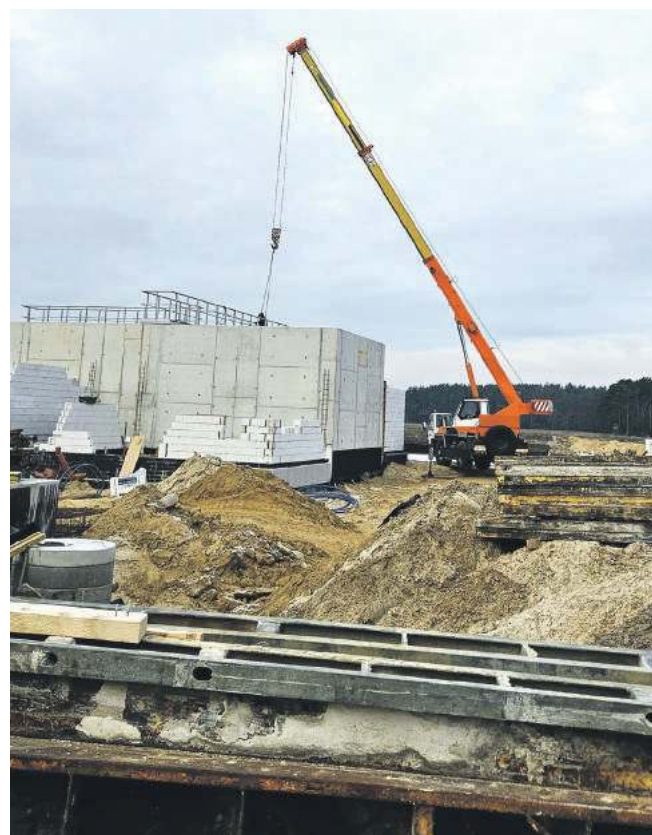
Budowa oczyszczalni ścieków będzie miała swój finał we wrześniu
