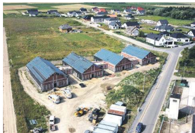
Budowa centrum opiekuńczego - mieszkaniowego dla osób samotnych i starszych
