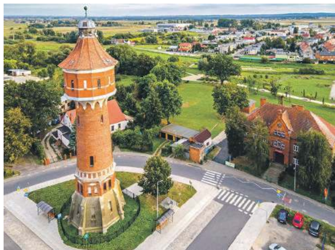
Zabytkowa wieża ciśnień. W tym roku zostanie wymienione pokrycie dachowe i odnowiona elewacja
