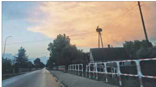
Jeszcze niedawno na słupie energetycznym w Polinowie było bocianie gniazdo. Ostatnio zniknęło, ale PGE zapewnia, że bociany do miejscowości wrócą
