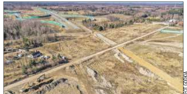
Dla odcinków Kałuszyn – Groszki i Gręzów – Siedlce Zachód wydane zostały już decyzje o zezwoleniu na realizację inwestycji drogowej. Prace budów zostały przekazane przez GDDKiA wykonawcom, a roboty w terenie już trwają
