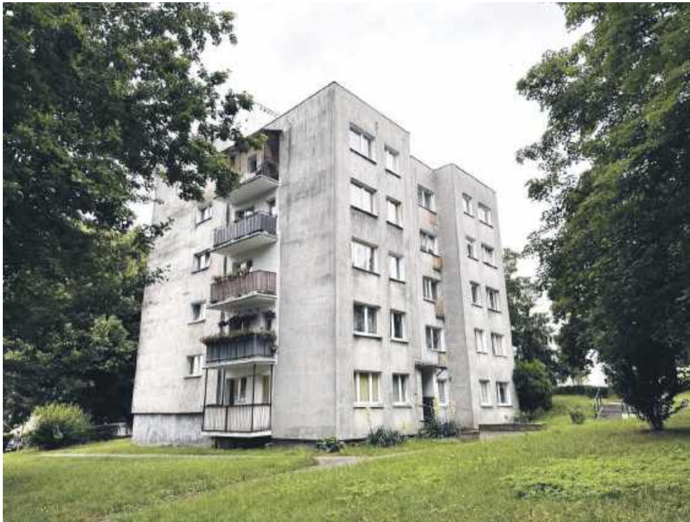
Cały blok został odcięty od gazu
