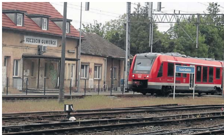
Stacja Szczecin Gumieńce ma być zmodernizowana
