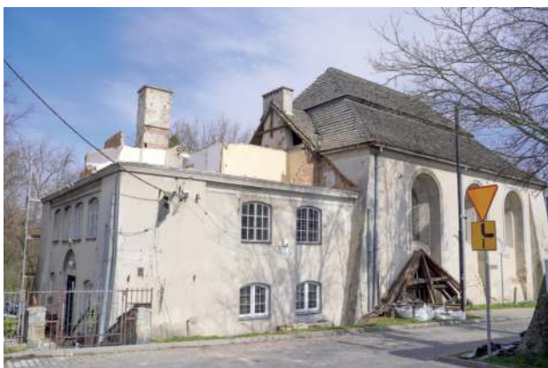
Obecny stan budynku po częściowej rozbiórce dachu
