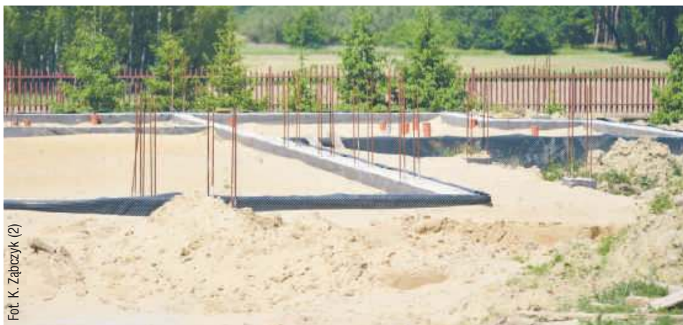
Tak wygląda aktualnie plac budowy.
