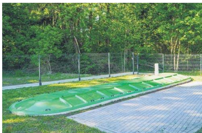
Budowa oczyszczalni ścieków w miejscowości Chwalimki
