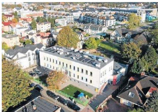
FOT. GMINA MIĘDZYDROJE
