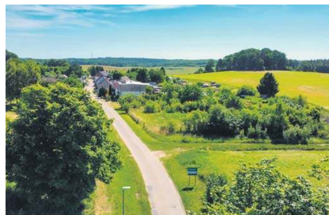
Przebudowa drogi do miejscowości Tarmno
