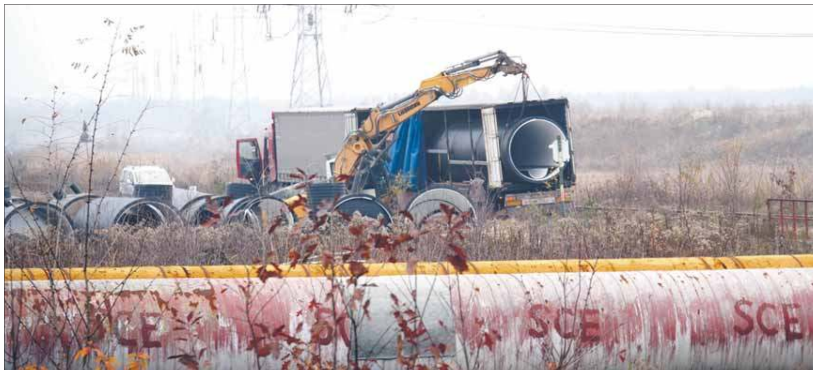
Budowa rurociągu na Izerze
