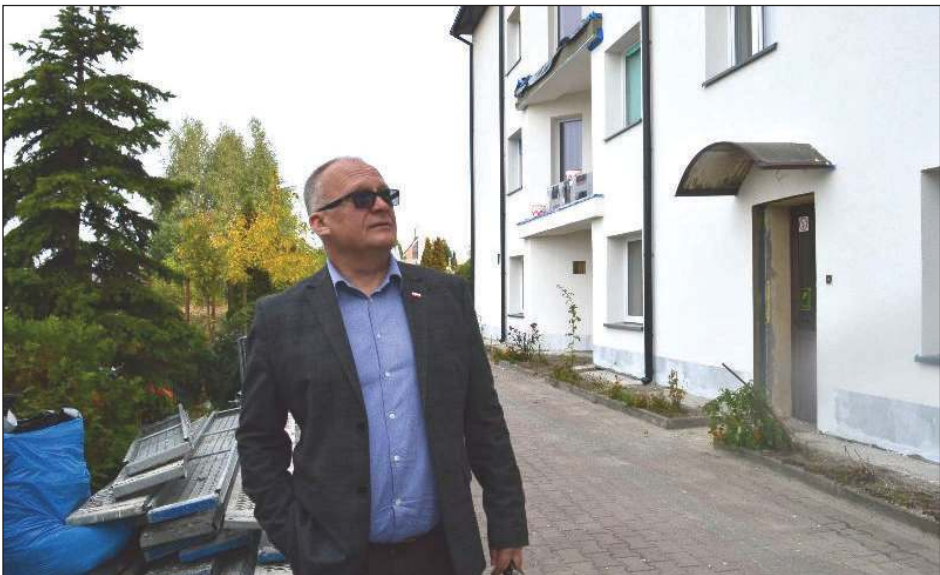
■ Budowlańcy kończą prace przy termomodernizacji Domu Pomocy Społecznej w Leopoldowie. - Budynki naszych jednostek, w szczególności szkół, są niestety bardzo zaniedbane - mówi starosta Dariusz Szczygieski
