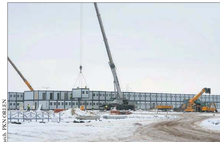
arch. PKN ORLEN Powstaje miasteczko dla pracowników zatrudnionych przy budowie instalacji Olefiny III
