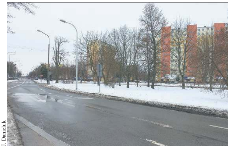
Na ulicy Chopina – na wysokości dworca kolejowego – powstanie rondo, które poprawi bezpieczeństwo ruchu drogowego w tym miejscu
