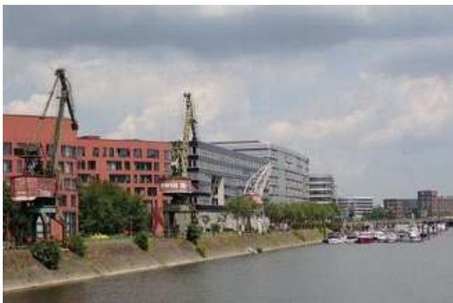
Żurawie portowe wkomponowane w nowoczesną zabudowę
