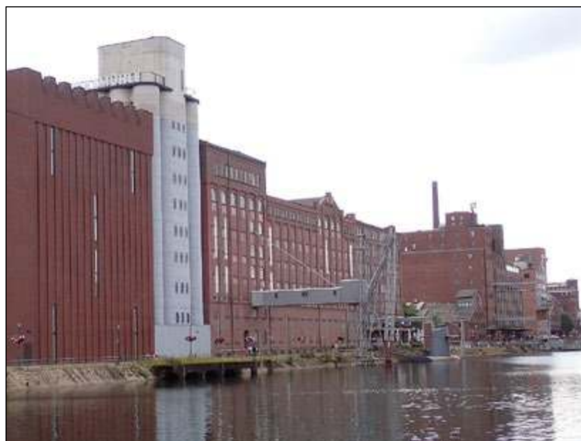
Dawne spichlerze Küppersmühle oraz Werhahnmühle
