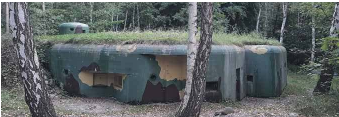
Bunkier „Sabała” – centrum dowodzenia Ośrodka Oporu Jastarnia – latem otwarty dla zwiedzających.
