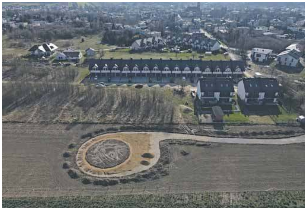
Na obrzeżach Bobrownik Śląskich trwa budowa zielonej przestrzeni o charakterze edukacyjno-rekreacyjnym
