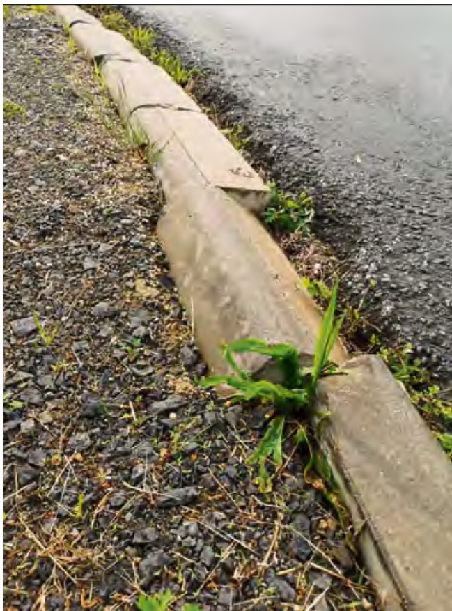
Uszkodzony krawężnik na skrzyżowaniu ulic Meblarskiej i Osiedle Fabryczne obrazuje problem zbyt cięsnego łuku drogi, na którym samochody ciężarowe nie mieszczą się podczas skrętu.
