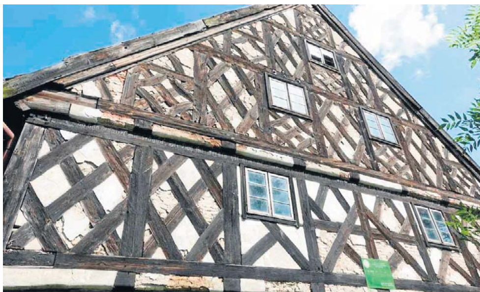
Dom ze Stalewa to konstrukcja typowa dla architektury Żuław - z murowanym przyziemiem i szkieletową górną kondygnacją
