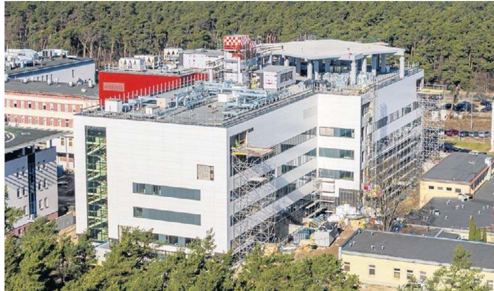
Sercem lecznicy będzie nowoczesny pięciokondygnacyjny budynek. Budowa trwa
