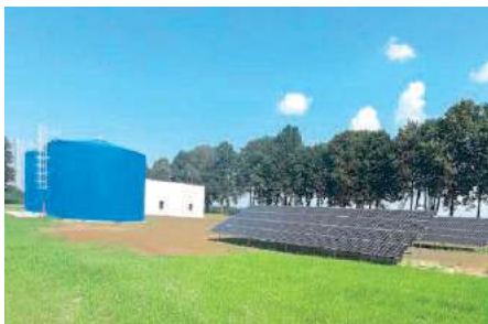
Stacja uzdatniania wody w Abramowie wraz z fotowoltaiką
