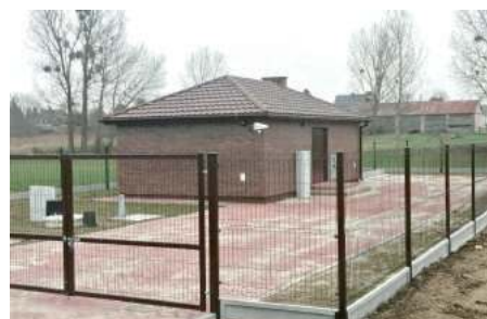
Budynek przepompowni w miejscowości Wielkolas
