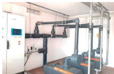
Oczyszczalnia ścieków w Wielkiem po remoncie
