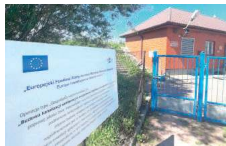
Oczyszczalnia ścieków w Wielkiem po modernizacji
