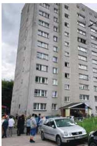
■ Mieszkańców bloku ewakuowano na zewnątrz budynku
