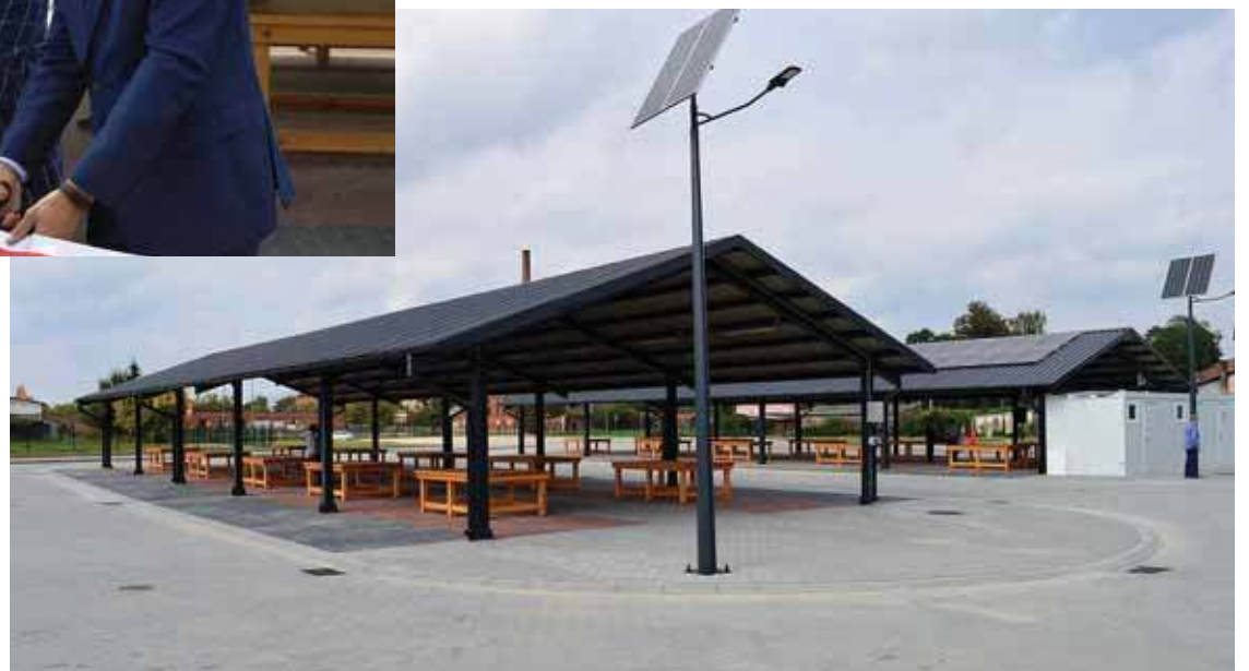
Zmodernizowany obiekt posłuży lokalnym handlarzom i społeczności.
