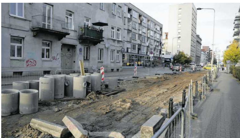
• Warszawa. Remont ul. Okrzei, 31 października 2025 r.
